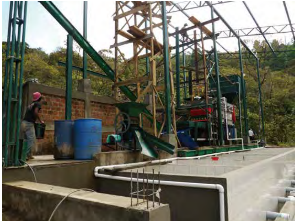
←農園内に建設中の生産処理場。建屋は建設中ですが、機械はすでに稼働していました。
